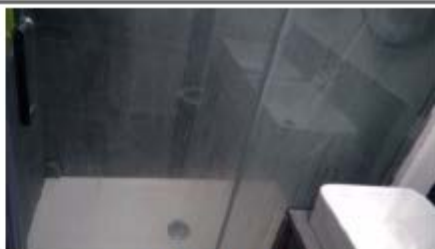
Salle d'eau / WC 2
