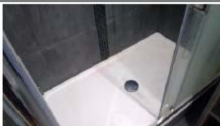
Salle d'eau / WC 2
