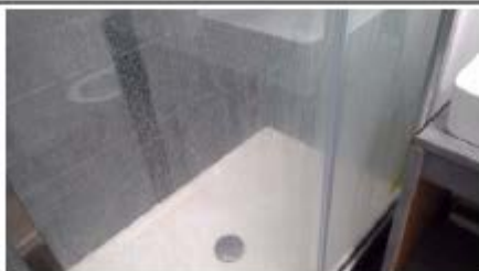
Salle d'eau / WC 2
