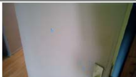
Chambre 2 : Porte Bois peint
