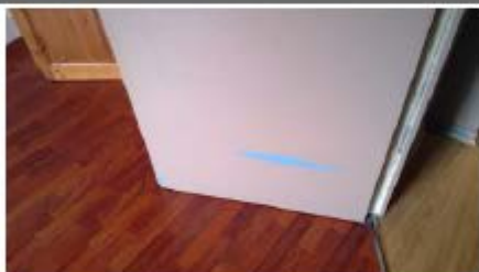
Chambre 1 : Porte Bois peint
