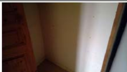
Chambre 2 : Placard intérieur peint
