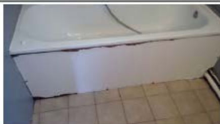
Salle de bains : Baignoire : Tablier Bois
