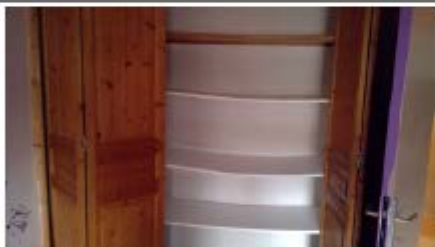
Chambre 1 : Placard intérieur peint
